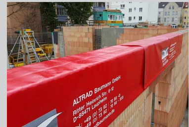
Die neueste Entwicklung in Sachen Nässeschutz für Mauerwerke ist die Mauerplane
