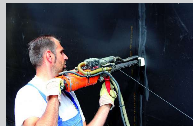
Die ABG-Dichtungsbahn wird thermisch verschweißt. Das garantiert 100%ige Wasserdichte.
