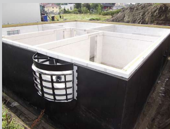
Wasserdichter Wohnraumkeller – dank ABG-Kellerdicht-System
