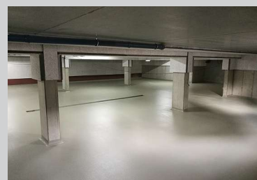
Hadalan GVS 12E eignet sich als Oberflächenschutzsystem nach OS 8 und damit auch für den Einsatz in Parkhäusern und Tiefgaragen.
