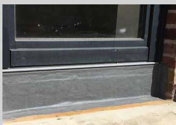
Mit Imberal DAB 30P lassen sich auch komplizierte und schwer zugängliche Konstruktionen abdichten.
