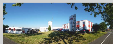
Büro- und Produktionsgebäude in Würzburg
