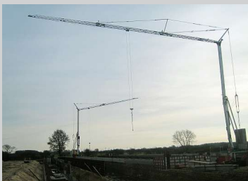
BKL System Cattaneo Schnellmontagekrane CM 90S4 mit 41 m Ausladung und CM 271 mit 27 m Ausladung beim Bau eines Gebäudes bei Bremen.
