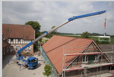
Der markante Klaas Ausleger erzielt hervorragende Ausladungswerte dank seines geringen Eigengewichts.
