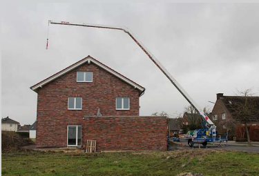
Enorme seitliche Reichweiten ermöglichen einen Materialtransport auch auf die rückwärtige Dachseite ohne Umsetzen des Krans.
