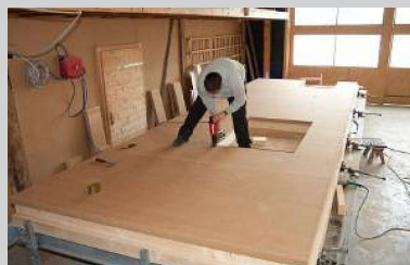
Ein Großteil der Wandelemente kann unabhängig von Witterungseinflüssen vorgefertigt werden
