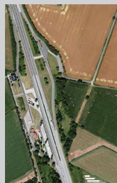
BIM-Pilotprojekt "Ausbau der Rastanlage Ellund an der BAB A 7"
