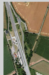
BIM-Pilotprojekt „Ausbau der Rastanlage Ellund an der BAB A7
