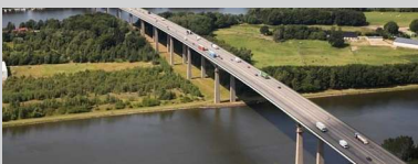
Brückenbauprojekt Rader Hochbrücke im Zuge der A 7
