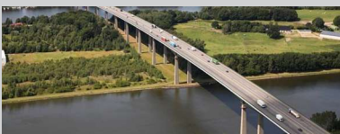
Brückenbauprojekt Rader Hochbrücke im Zuge der A 7
