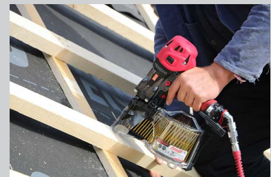
Geräte sind mit Knochengelenk ausgestattet. Kein Verdrehen des Schlauchs
