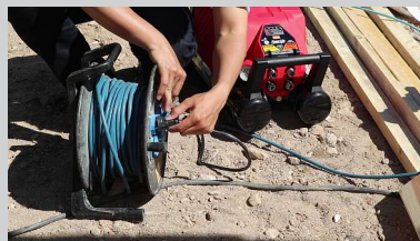
Kompressor arbeitet bis zu 140 Volt
